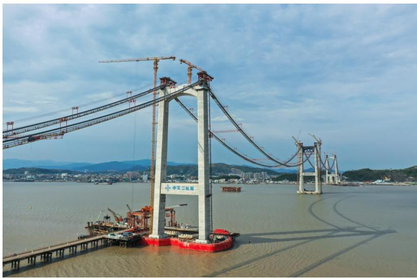
4月7日，随着下游侧第169根索股的成功架设，由公司承建的温州瓯江北口大桥主缆全部架设完成，大桥建设取得突破性进展。
