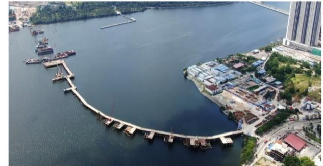
2月22日，经过建设者们43天奋战，由公司参建的马来西亚柔新捷运系统水上段高架（RTS）项目主桥P47墩23根桩基完成浇筑，这也是项目完成的第一个主墩所有桩基础，向后续主墩深水承台施工迈出坚实一步。
