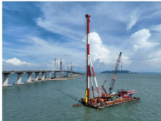
2月5日，随着P10墩最后一根钢管桩成功施沉，中国港湾承建、中交二航局参建的马来西亚槟城275KV跨海输电线路项目海上首个承台桩基施工完成。
